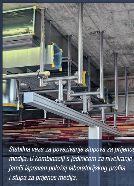
3-dimenzionalni raster podkonstrukcije za pričvršćivanje u slučaju velike gustoće instalacija i visokih zahtjeva za fleksibilnošću.
