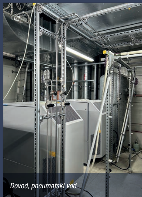
3-dimenzionalni raster podkonstrukcije za pričvršćivanje u slučaju velike gustoće instalacija i visokih zahtjeva za fleksibilnošću.
